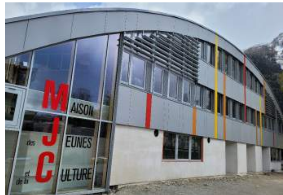
Travaux de rénovation énergétique de la MJC / Maison pour tous
