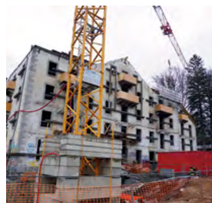
Le Grand Hôtel Couttet, actuellement en travaux, ouvrira fin 2024
