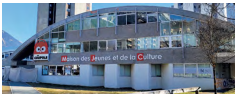
La Maison pour tous bénéficie en 2023 d'une rénovation énergétique complète
