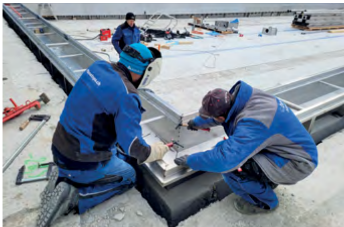
Soudure des différents éléments en inox
