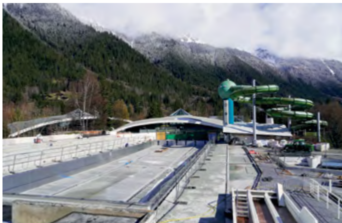
Construction du bassin extérieur de la piscine en inox
