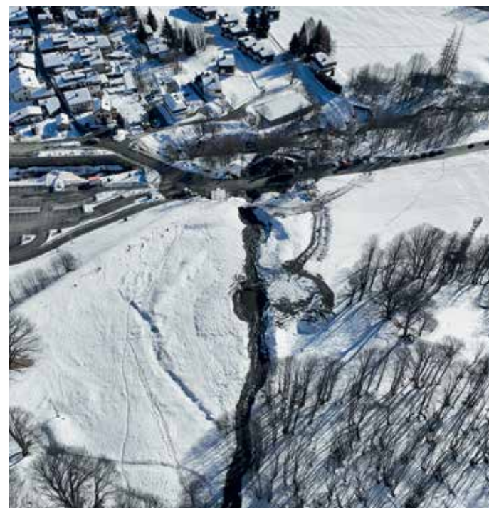
Le débordement du Nantet coupe l'accès au village du Tour
