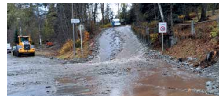
Écoulement d'eau aux Nants
