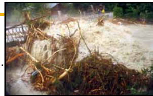
Pont de la Plage crue de 1996
