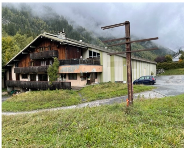
L'ancien bâtiment à démolir
