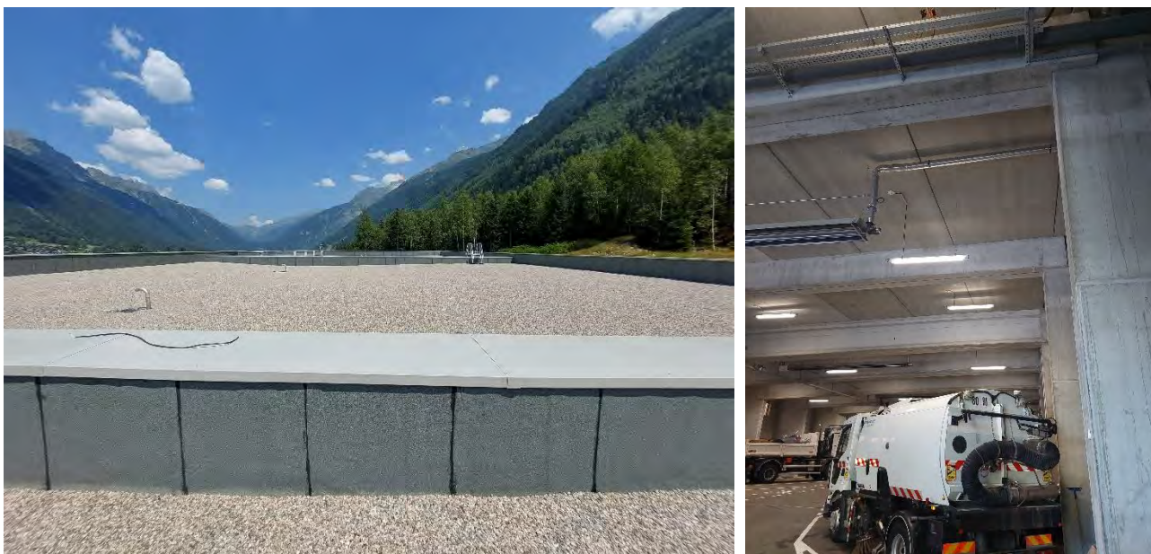
Figure 3 - Photos de couverture (à gauche) et de la structure porteuse du bâtiment (à droite)
